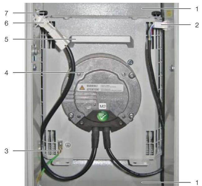
Fig. 21: Fan module in fan tray
