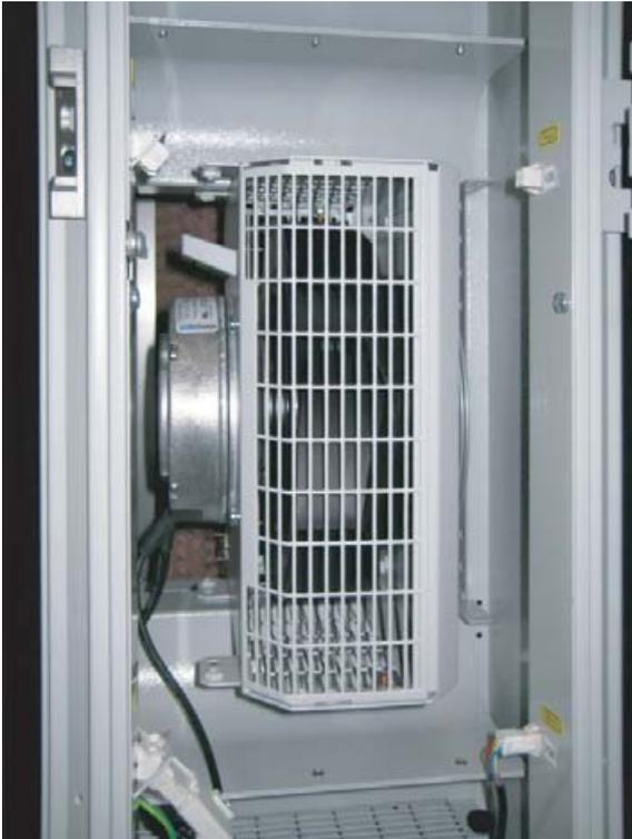
Fig. 22: Rotated fan module in fan tray
