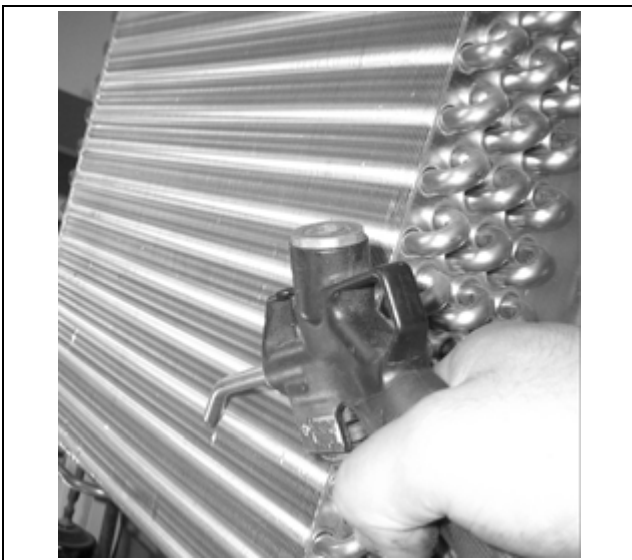
Abb. 47: Verflüssiger reinigen
