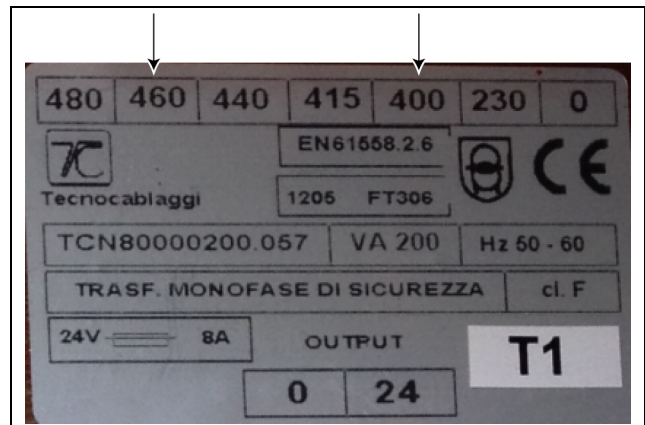
Abb. 29: Transformatoranschluss
