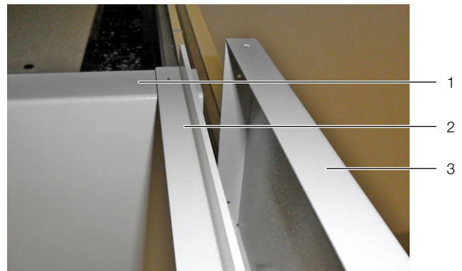
Abb. 53: Dachwinkel über der Tür der Gang-Schottung
