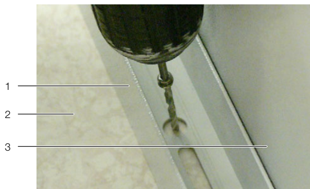
Abb. 8: Vorbohren der Befestigungslöcher
