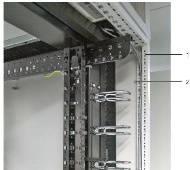
Abb. 10: Verschrauben der Seitenwand
