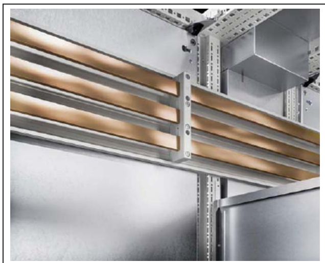
Fig. 11: Passaggio nella parte superiore
