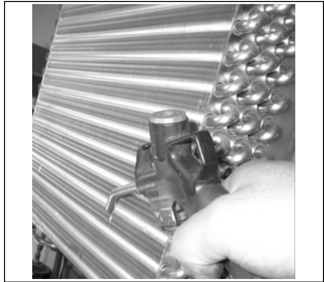
Fig. 47 : Nettoyage du condenseur
