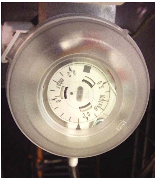
Рис. 59: Винт настройки датчика перепада давления
