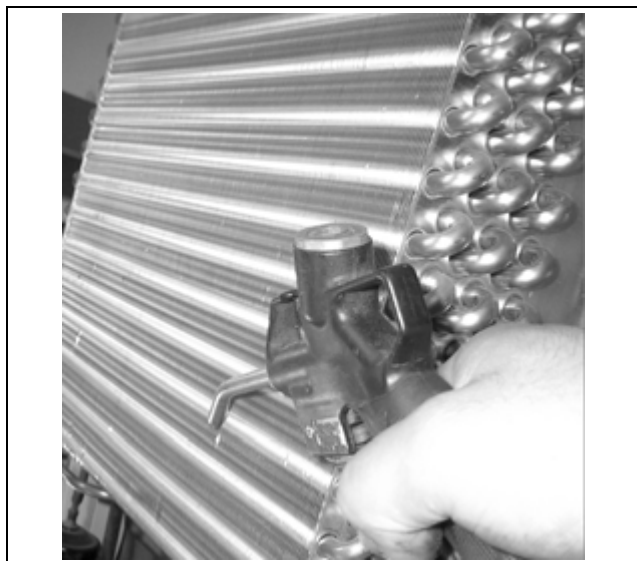
Рис. 47: Чистка конденсатора
