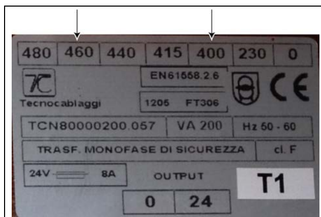
Obr. 29: Zapojení transformátoru
