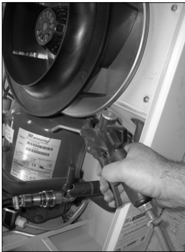
Fig. 52: Limpar os tubos do trocador de calor e o compartimento do compressor com ar comprimido (2)
