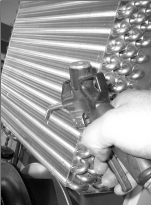
Afb. 75: Warmtewisselaarregister en compressorruimte met perslucht doorblazen (2)
