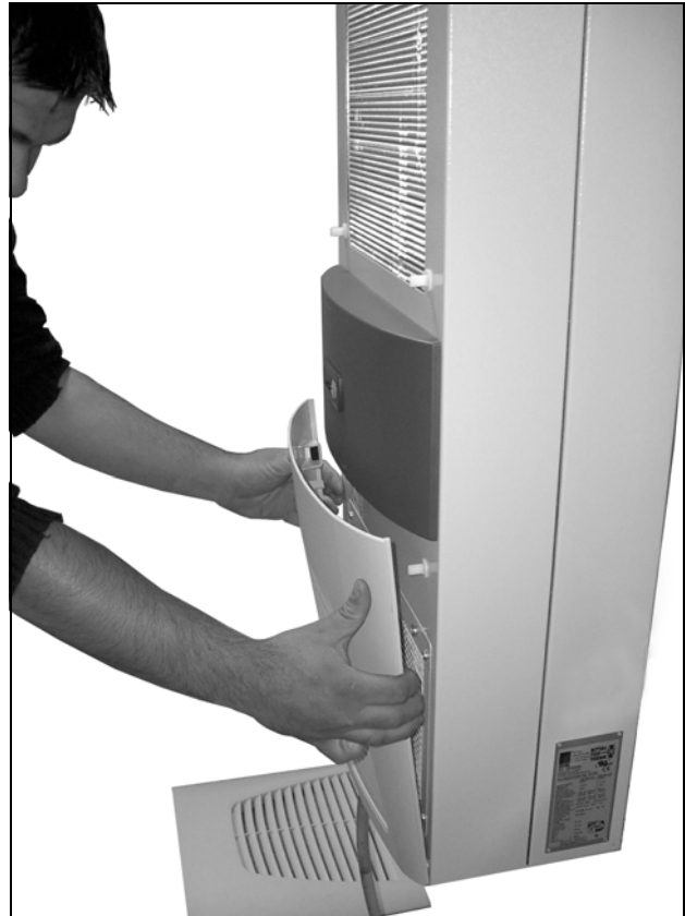
Afb. 36: Onderste ventilatierooster verwijderen
