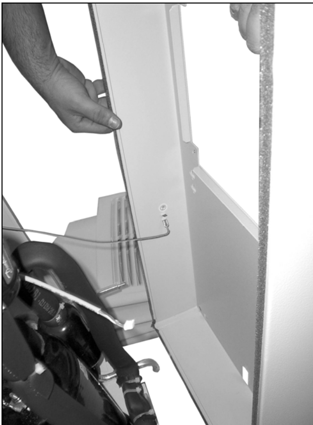
Obr. 72: Odpojení uzemňovacího kabelu (1)
