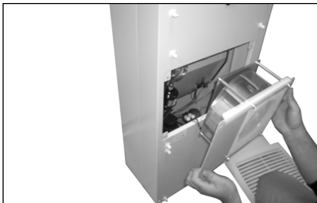
Obr. 64: Demontáž ventilátoru vnějšího okruhu
