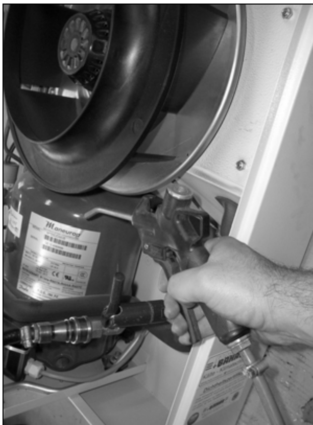
Obr. 76: Vyfoukání žeber výměníku tepla a prostoru kompresoru stlačeným vzduchem (3)
