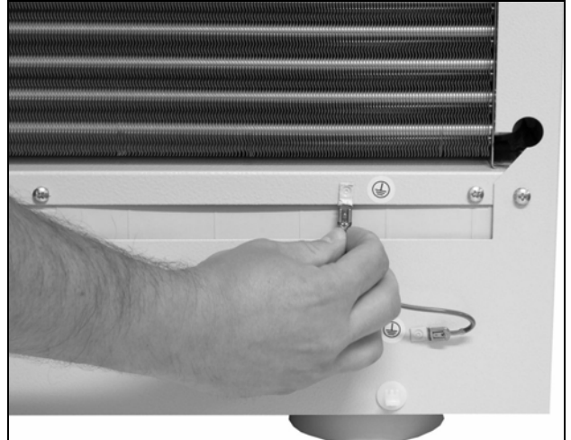
Bild 25: Dra ut jordningskabel
