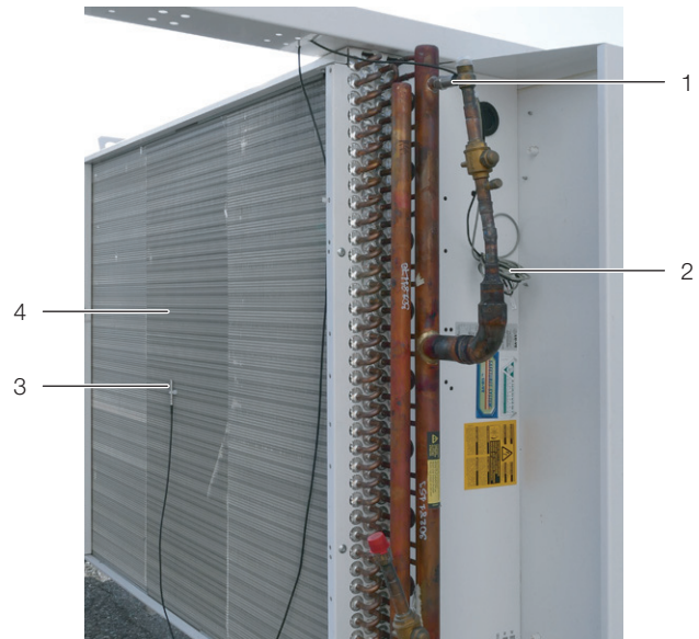
Abb. 32: Anschluss der Sensoren
