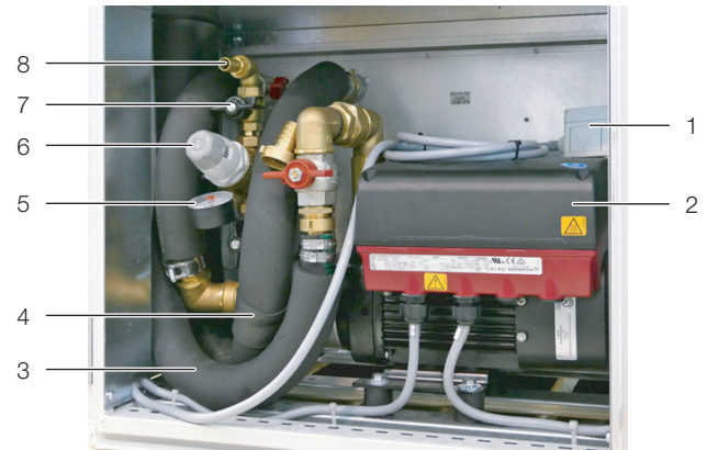
Abb. 6: Wasserkreislauf – vorne unten im Gerät
