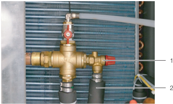
Abb. 27: Sicherheitsventil auf der Rückseite
