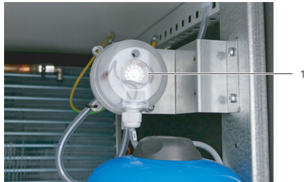
Abb. 64: Einstellschraube am Differenzdrucksensor
