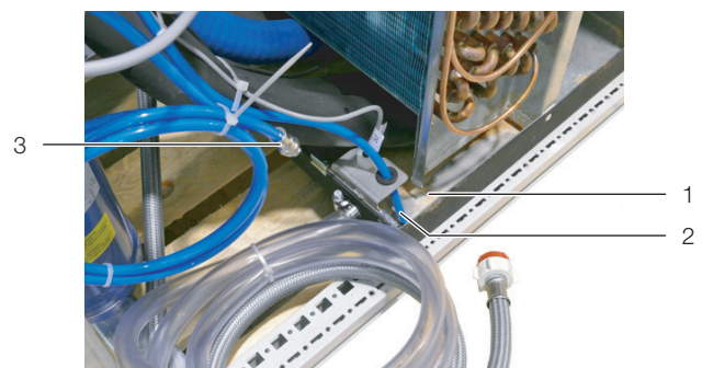
Abb. 63: Anschlüsse der Kondensatpumpe
