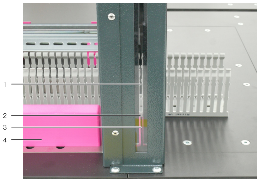
Rys. 13: Wyrównanie koryta kablowego
