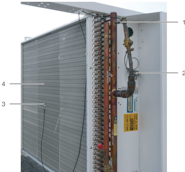
Abb. 32: Anschluss der Sensoren
