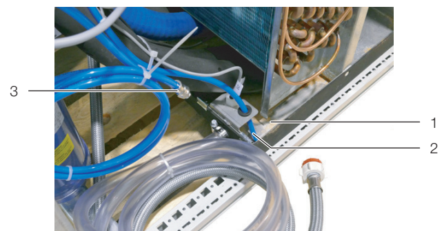
Abb. 63: Anschlüsse der Kondensatpumpe
