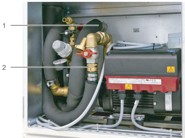
Abb. 23: Anschlusspunkte unten im Gerät
