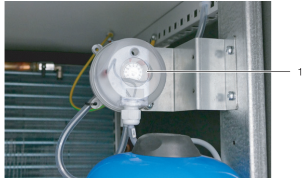
Abb. 64: Einstellschraube am Differenzdrucksensor
