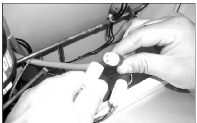
图72: 断开风扇接头 (3)
