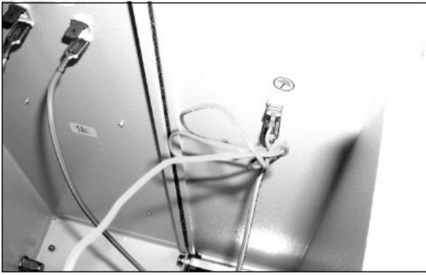
图73: 断开风扇接地电缆 (1)
