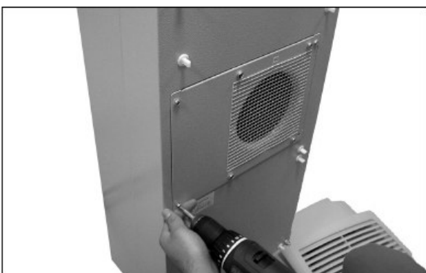
图68: 松开外部管路风扇上的四个螺钉
