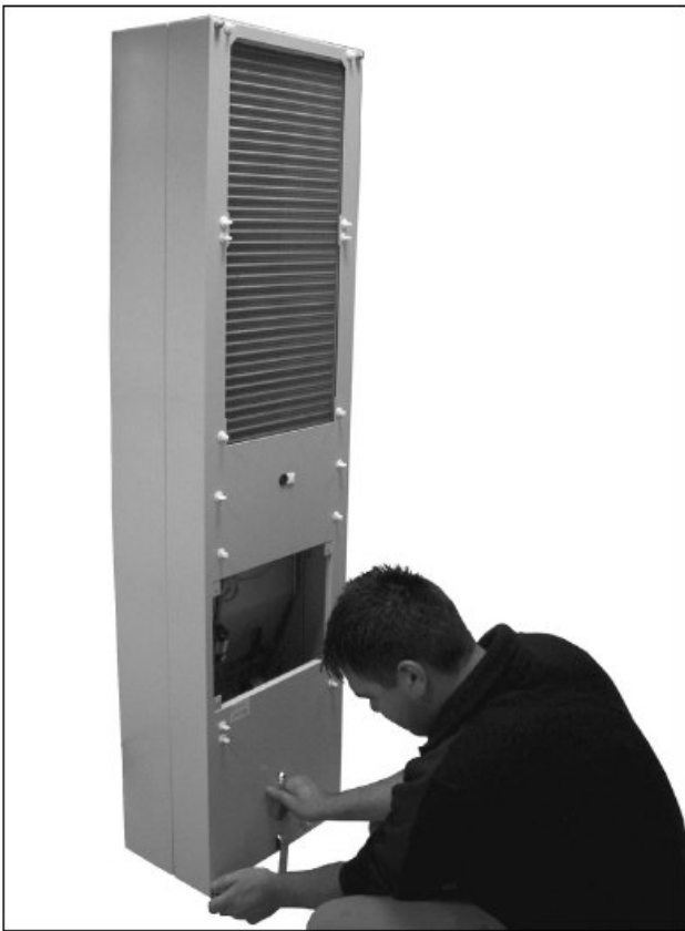
图75: 松开盖子上的四个螺钉
