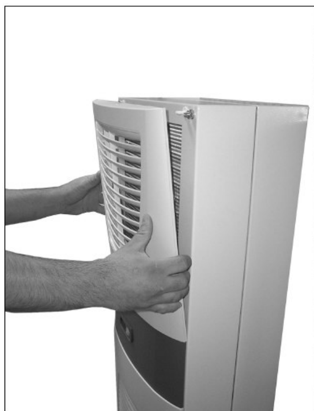
图40：拆卸上百叶窗格
