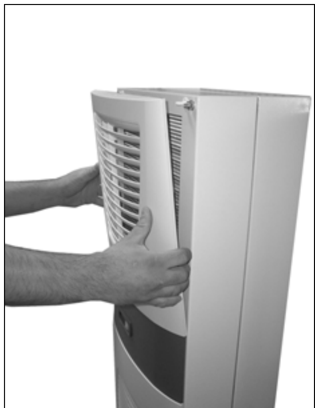
Abb. 40: Oberes Lamellengitter entfernen
