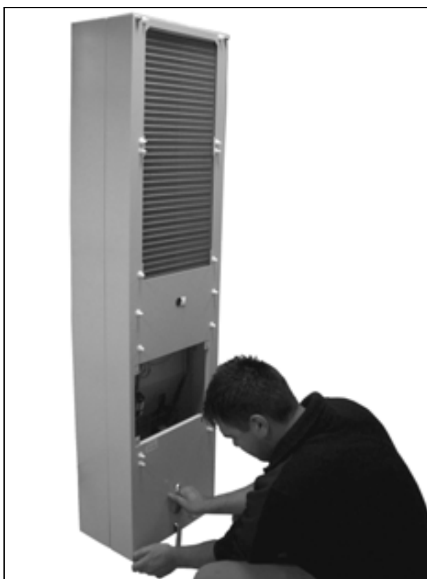
Abb. 75: Vier Muttern der Haube lösen
