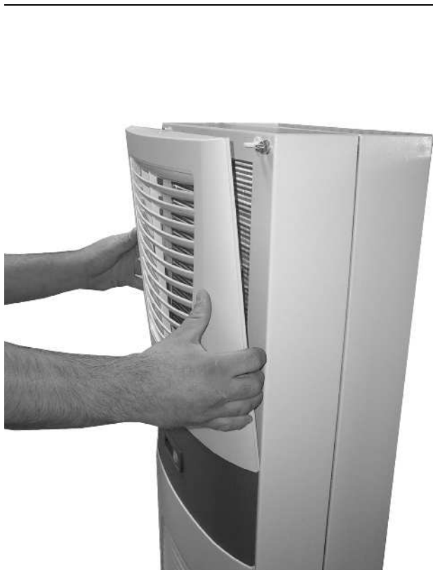
Afb. 39: Bovenste ventilatierooster verwijderen
