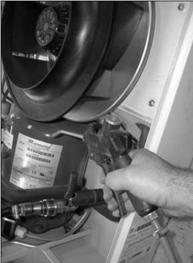
Afb. 56: Warmtewisselaarregister en compressorruimte met perslucht doorblazen (2)
