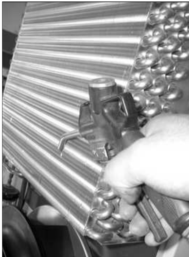
Afb. 55: Warmtewisselaarregister en compressoruimte met perslucht doorblazen (1)
