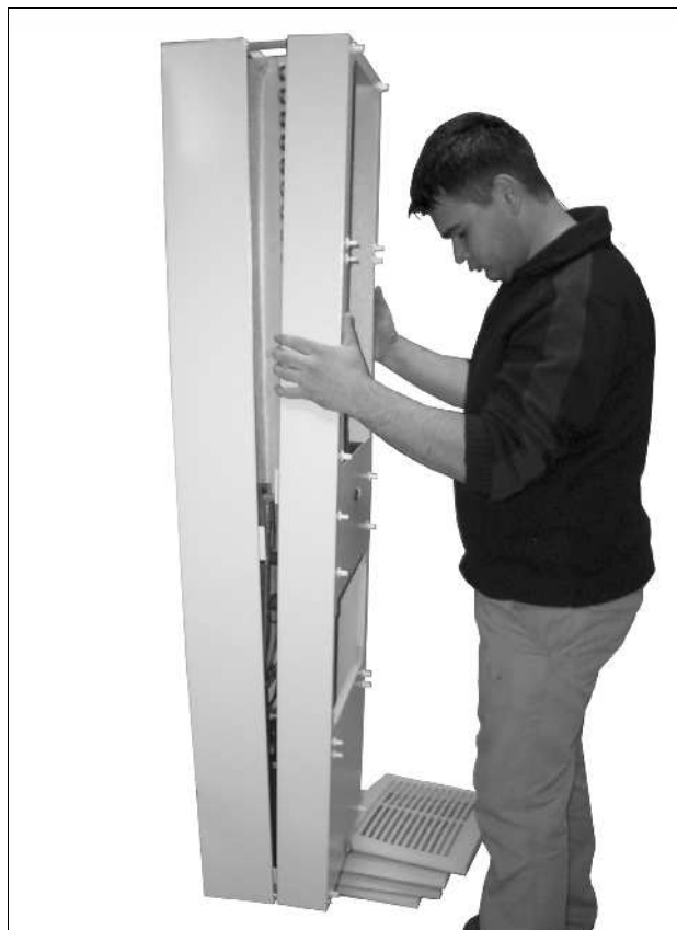
Afb. 75: Afdekkap verwijderen
