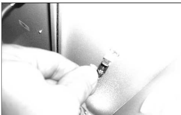
Afb. 73: Aardingskabel van de ventilator losnemen (2)
