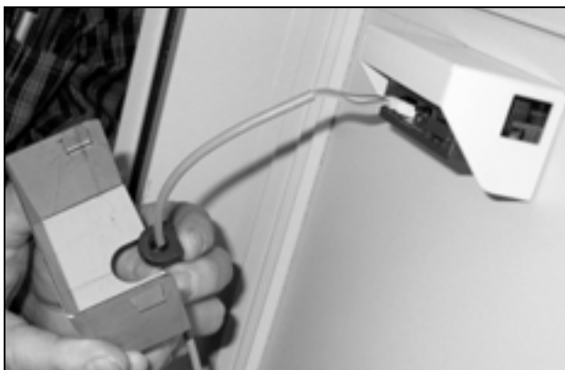
Abb. 16: Kabeltülle einführen
