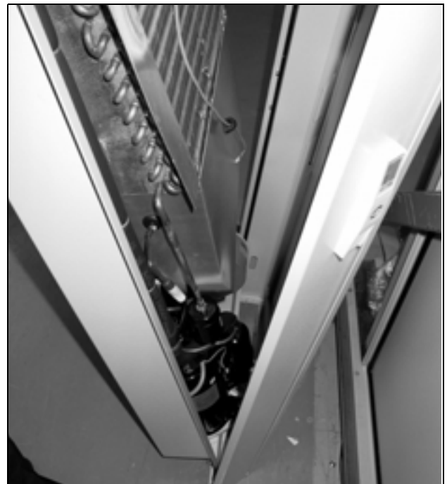
Abb. 8: Montage des Klimamoduls in die Profiltür
