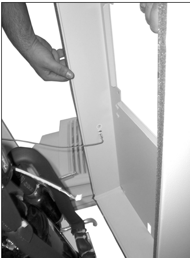
Imagen 72: Desconectar el cable de puesta a tierra (1)
