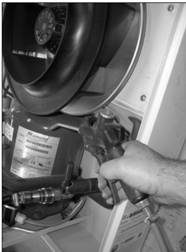
Imagen 76: Aplicar aire a presión en el registro del intercambiador de calor y el espacio del compresor (3)
