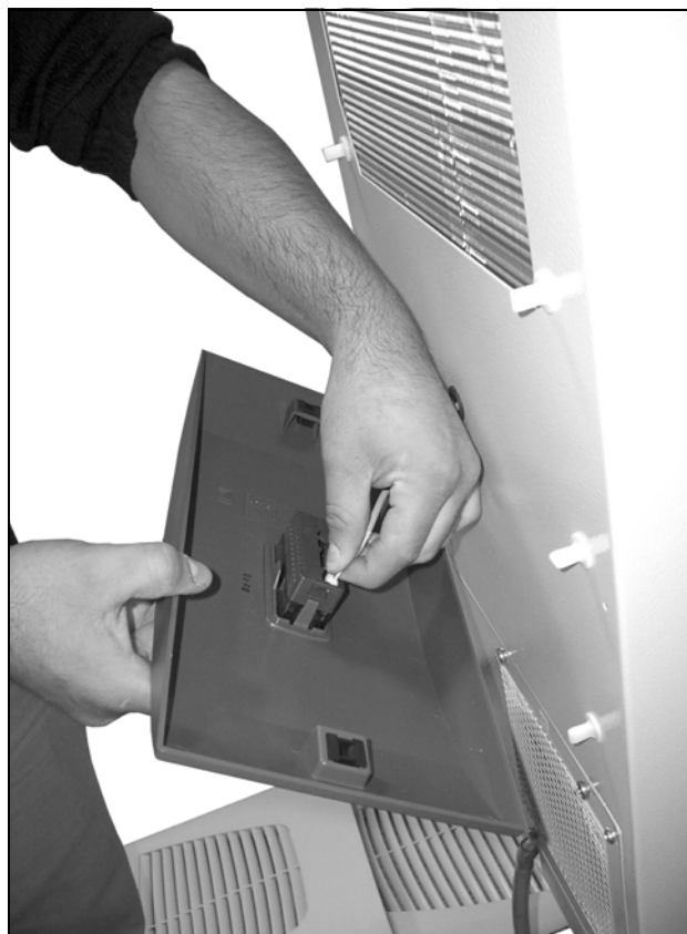
Рис. 43: Отсоединение штекера дисплея (1)
