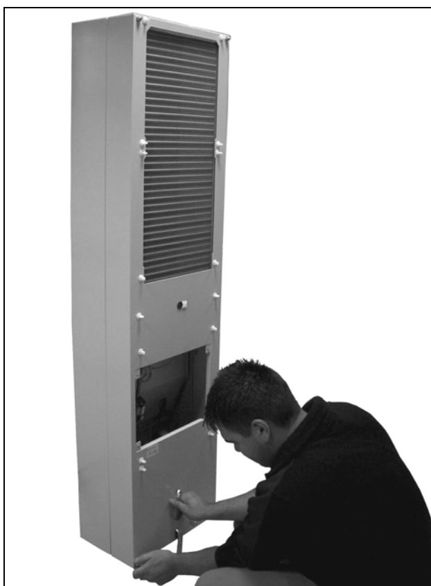
Рис. 75: Отвинчивание четырех винтов кожуха
