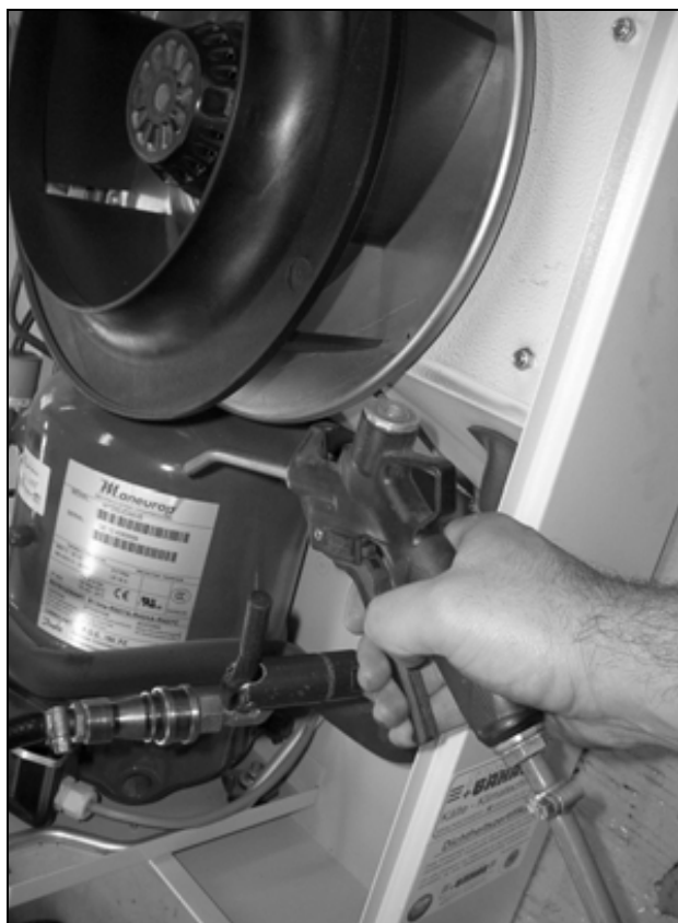
Рис. 81: Продувка теплообменного элемента и компрессорного отделения сжатым воздухом (3)
