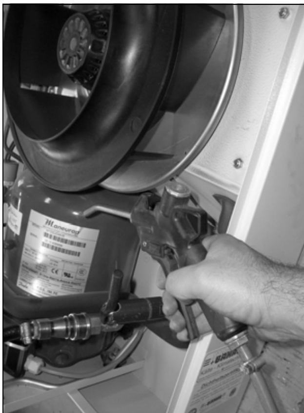
Рис. 57: Продувка теплообменного элемента и компрессорного отделения сжатым воздухом (2)
