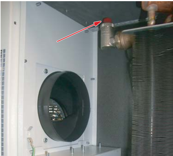
Рис. 41: Клапан удаления воздуха
