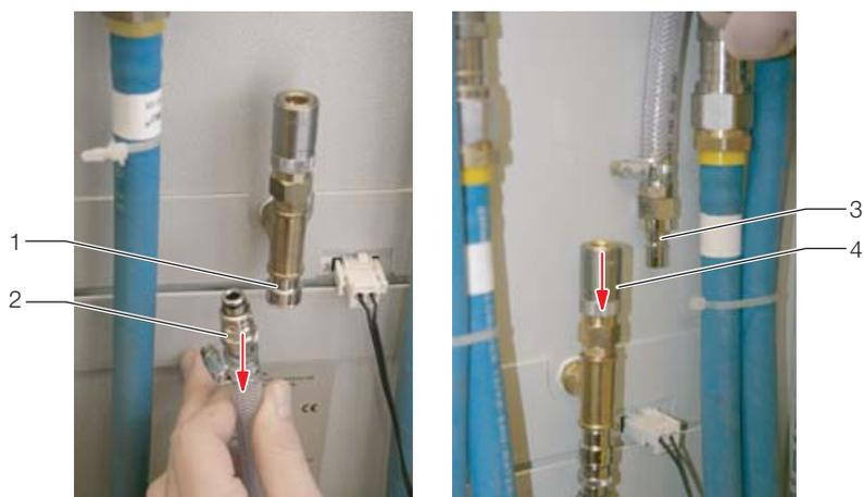
Рис. 32: Быстросъемная муфта на отводе конденсата
