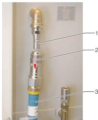
Рис. 31: Быстросъемная муфта на подводе охлаждающей воды
