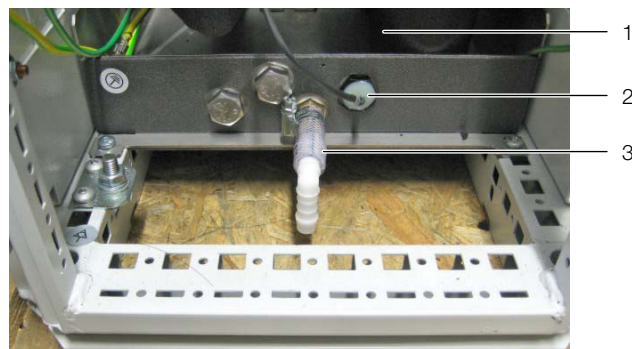
Рис. 52: Отвод конденсата
