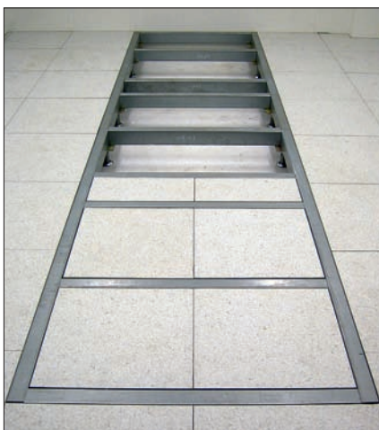
Asennusalustat ja varakentät
