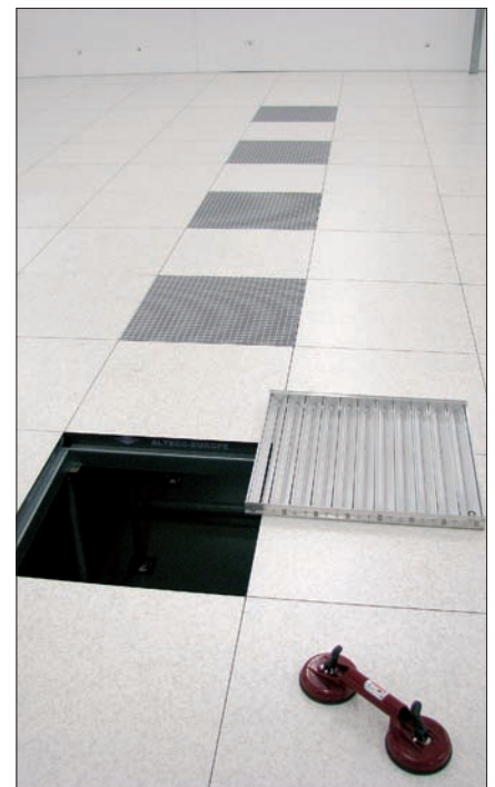
Ilmastointilaatta ALWA600 säätöritilällä
