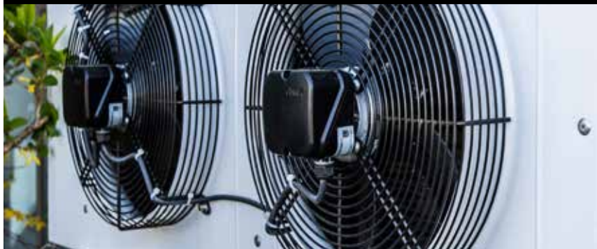
Die im Register aufgenommene Wärmeenergie wird am Standort des externen Verflüssigers an die Umgebung abgegeben, dadurch wird der Aufstellraum nicht aufgeheizt.
