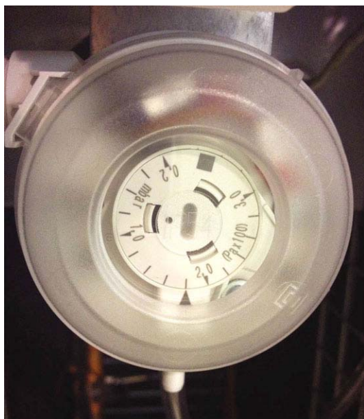
Рис. 59: Винт настройки датчика перепада давления
