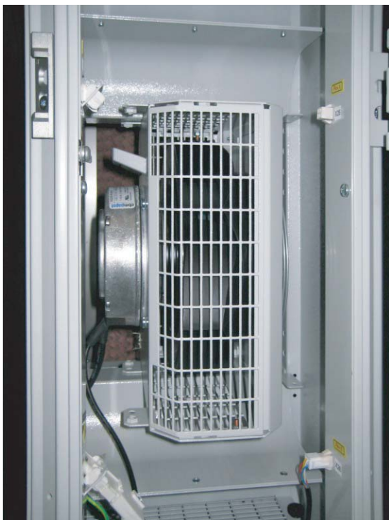
Рис. 20: Повернутый вентиляторный модуль в модульном отсеке
