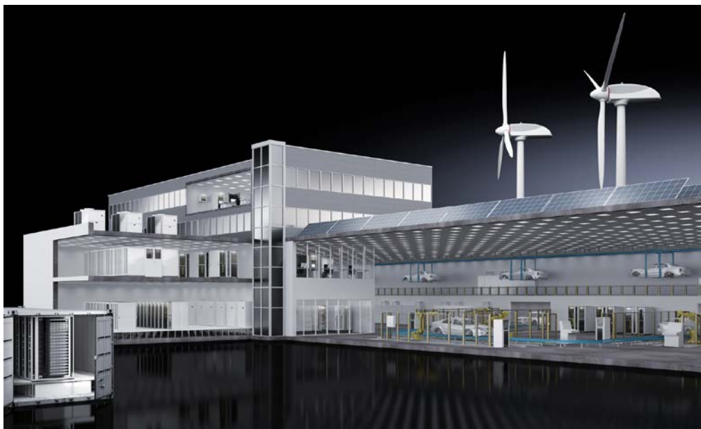
Abbildung 1: Das Rechenzentrum (links) als Basis für die industrielle Produktion.
