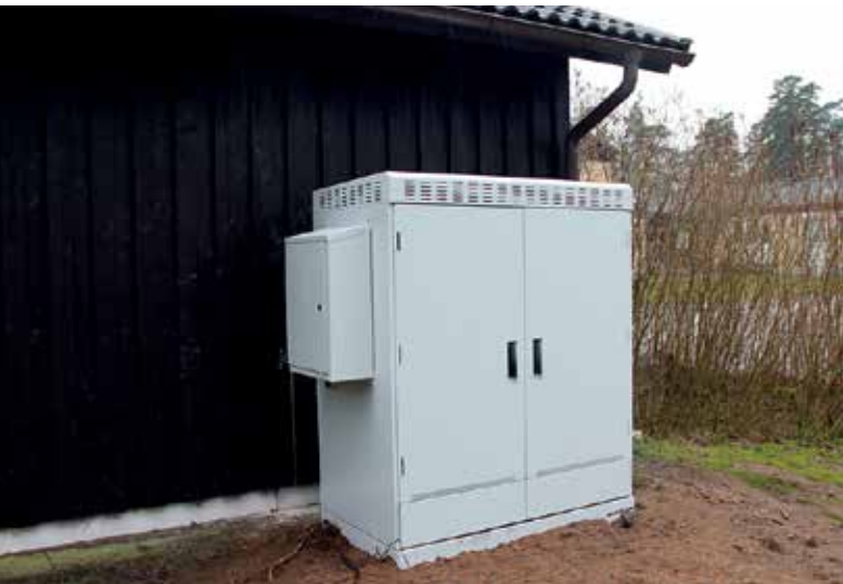
Rittals skåp för subnoderna sätts upp i tätorten och på 10-12 strategiska platser längs fiberstamnätet i den småländska skogen.
