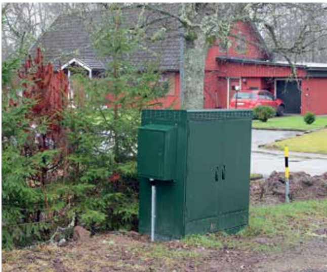
Rittals bredbandsskåp är inbrottslarmade och driftövervakade med larm. De kan utrustas med reservkraft för switchar och är byggda för passiv kylning med möjlighet att uppgradera till en aktiv klimatisering.
