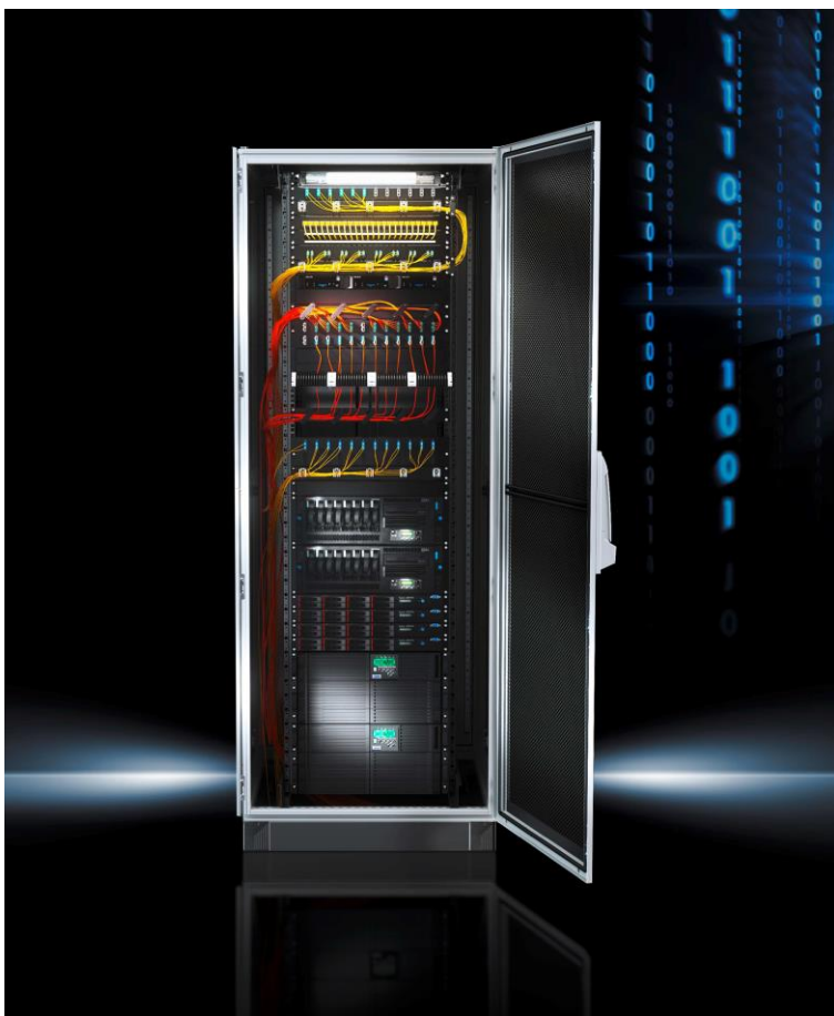
Rysunek 2. W układzie 42 U szafa 19-calowa osiąga wysokość około 2 metrów.
