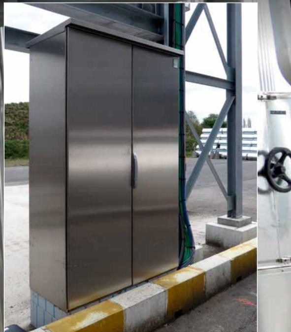
Pour le projet SunPine, on a opté pour l'armoire TS 8 en inox 304 de Rittal avec toit antipluie, car elle est montée à l'extérieur et exposée aux intempéries.
