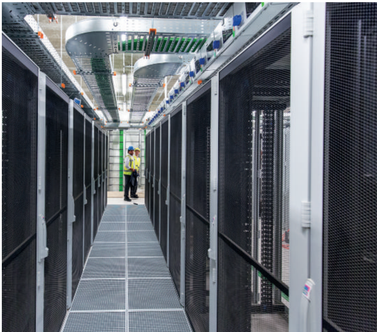
Aanleg IT infrastructuur in een van de twee main equipment rooms (MER)
