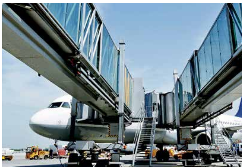
La tecnologia Rittal supporta il flusso continuo dei processi nelle diverse aree dell'aeroporto, tra cui quella dedicata all'impianto di smistamento dei bagagli e l'area della metropolitana.
