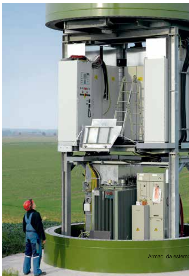
Enercon utilizza gli armadi Rittal per l'installazione degli inverter delle sue turbine eoliche
