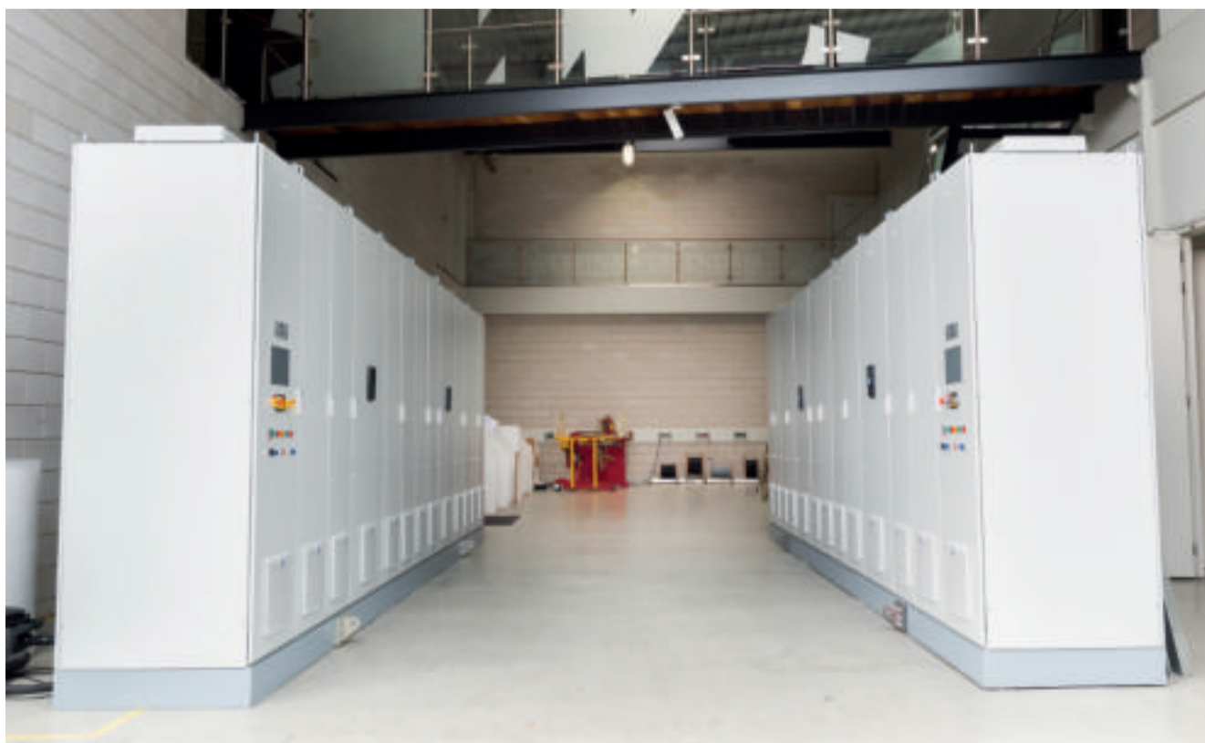
Het totale paneel is 50 meter en er zijn 45 dakventilatoren toegepast.
