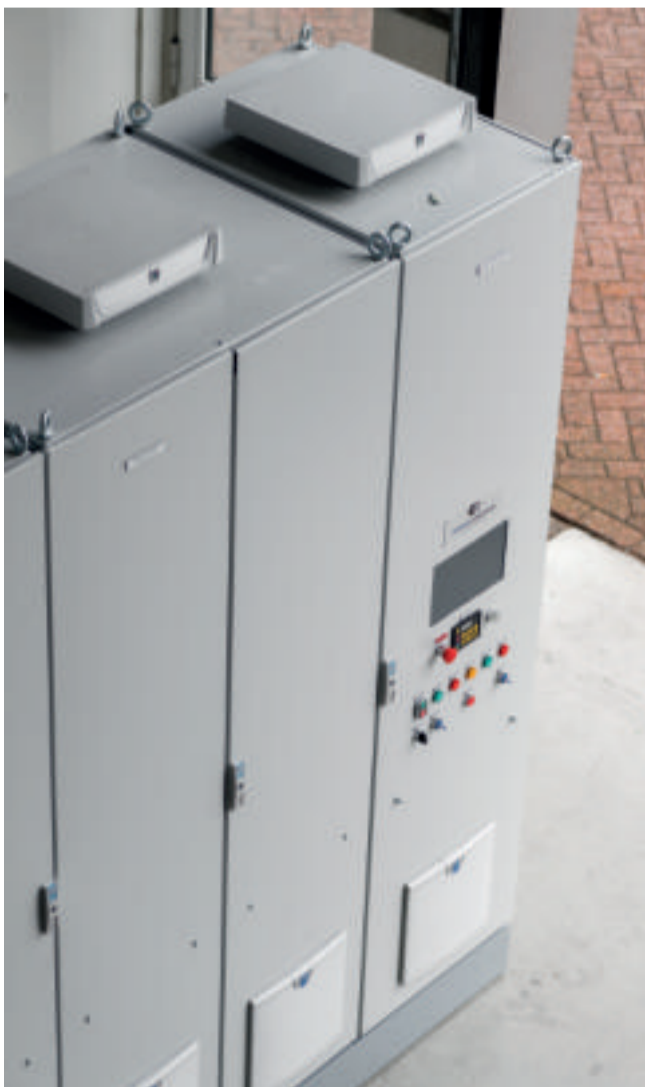
Op advies van Rittal heeft Werkina de nieuwste Rittal dakventilatoren toegepast, waardoor extra ruimte in de kast vrijkwam.
