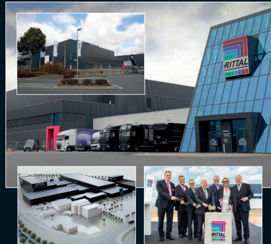
De nieuwe fabriek in Haiger - Van ontwerp tot het leggen van de eerste steen en een bijna afgewerkt gebouw.
