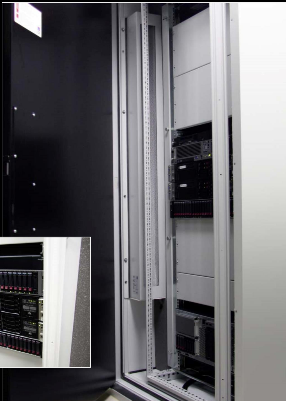
System monitorowania CMC III nadzorujący stany w sejfie
