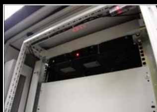
System monitorowania CMC III nadzorujący stany w sejfie
