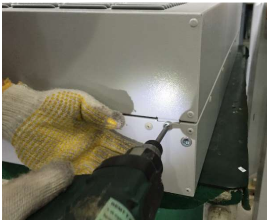
图 16: 拆卸空调盖顶部螺钉
