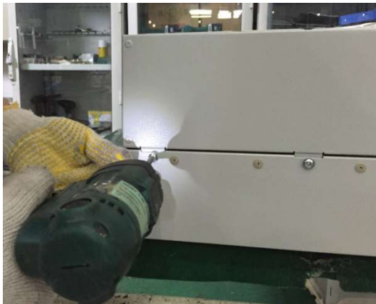
图 17: 拆卸空调盖底部螺钉
