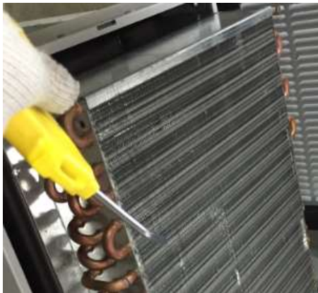
图 24: 用压缩空气清吹冷凝器盘管
