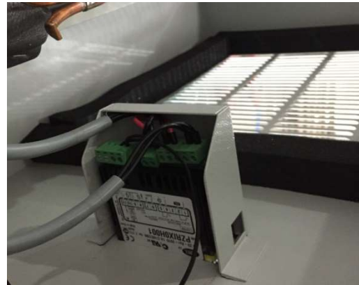
图 19: 从显示器上断开接头
