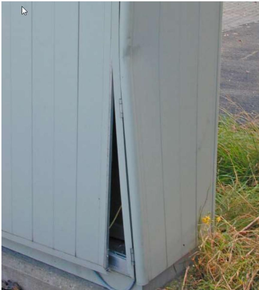
Photo 1 : coffret déformé sous l'effet d'une force extérieure
