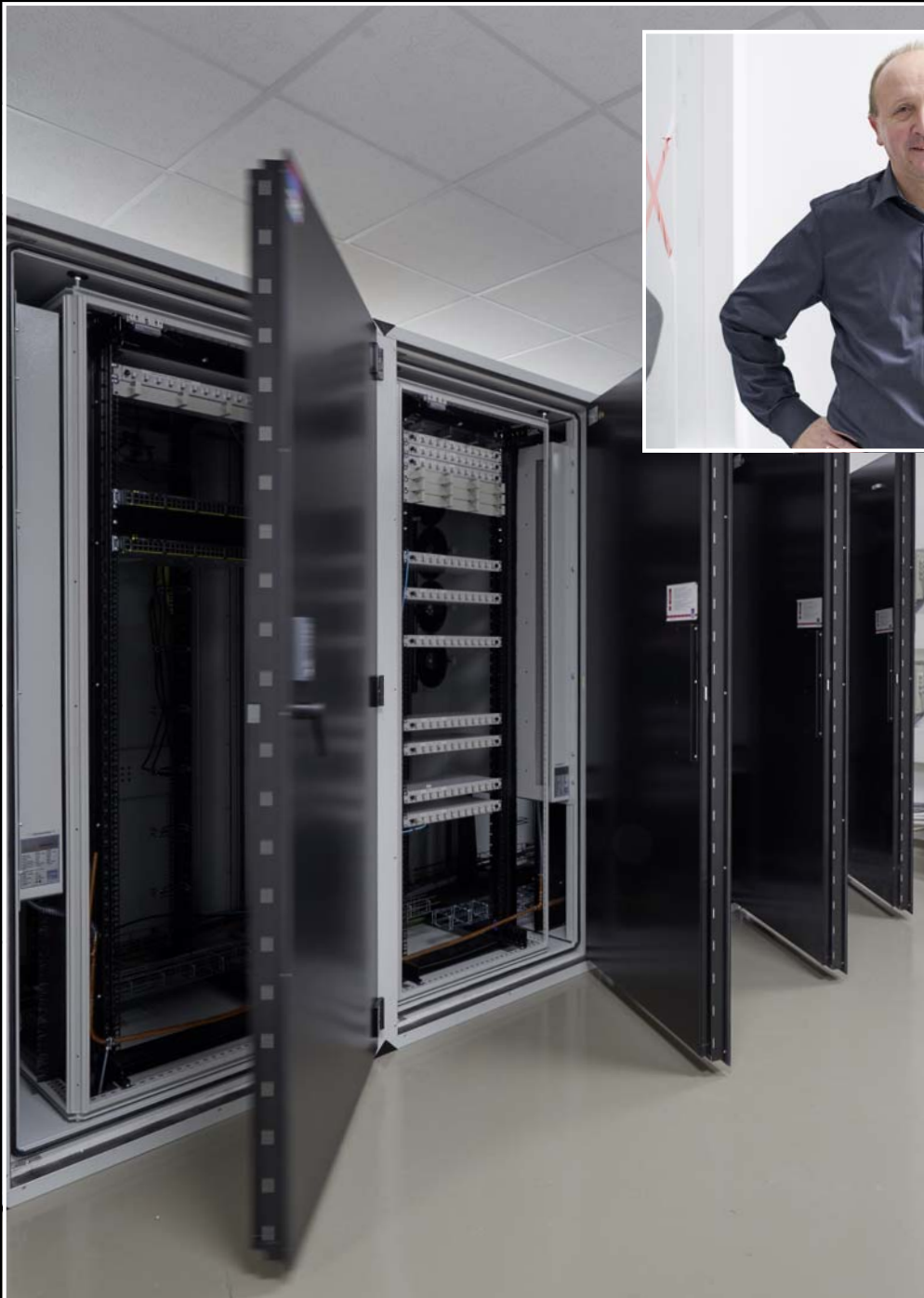
Verkettung von 4 Micro Data Center für den Schutz von 4 Server-Racks
