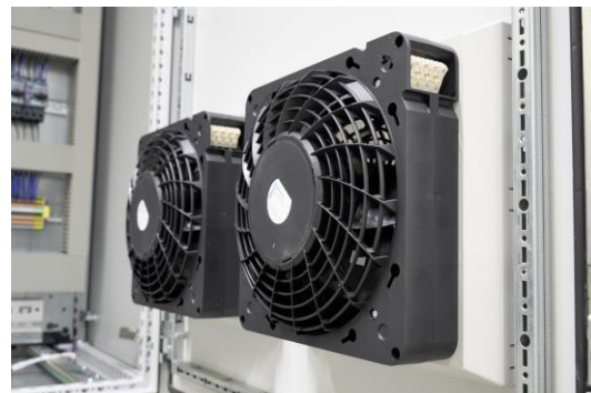
Filterventilatorer, der integreres via Rittals IoT-grænseflade, giver information om status, kapacitetsudnyttelse, driftstimer og energiforbrug.
