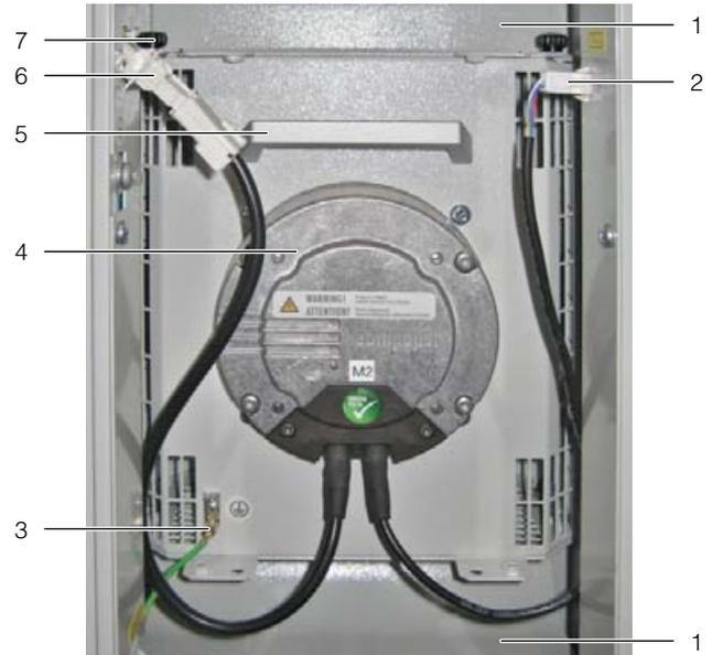
Fig. 31: Fan module in fan tray – LCP Inline flush version
