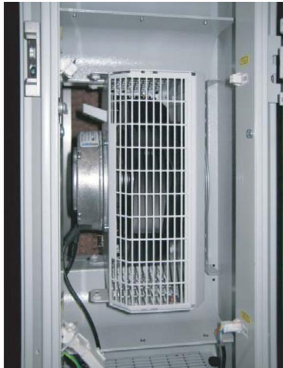
Fig. 32: Rotated fan module in fan tray – LCP Inline flush version
