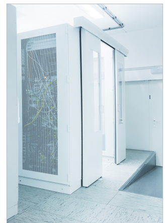
Die Gangschottung trennt die Luft. Das steigert die Energieeffizienz.
