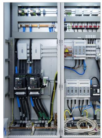
Eine redundante Stromanspeisung garantiert Ausfallsicherheit.
