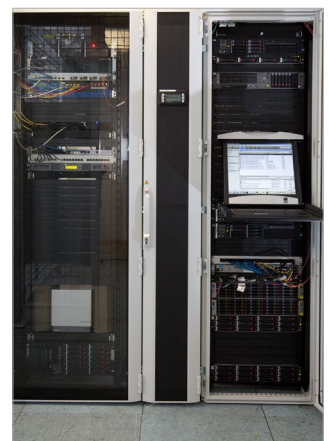
Je zwei TS IT Racks und zwei Einheiten des LCP DX sorgen für das richtige Klima.
