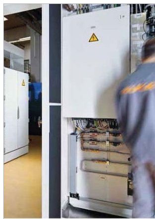
KUKA Industries verwendet den TS 8 bereits seit Markteinführung.
