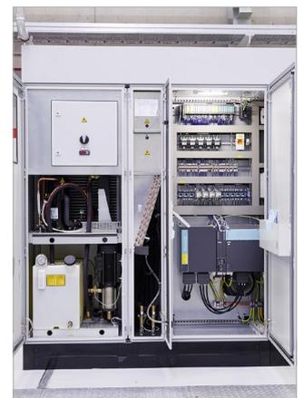
Im TS 8 integriert: die Kühlung LCP, ein Rückkühler und das RiLine60 Stromschienensystem.
