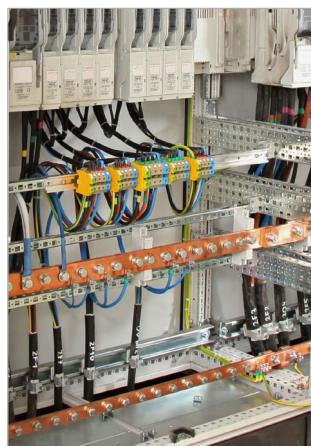
Das 185-mm-Sammelschienensystem ermöglicht einen sicheren und kompakten Aufbau.
