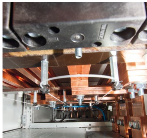
Verlegung des Lichtwellenleiters
