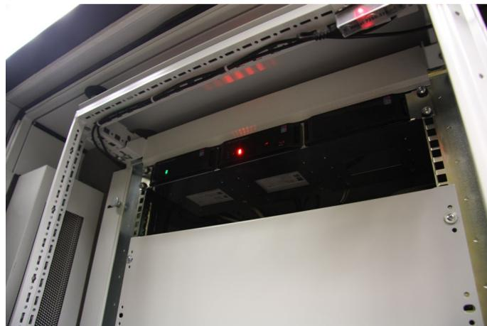
Die DET-AC III von Rittal ermöglicht durch die integrierte CAN-Bus Schnittstelle eine direkte Anbindung an das Monitoring System CMC III.
