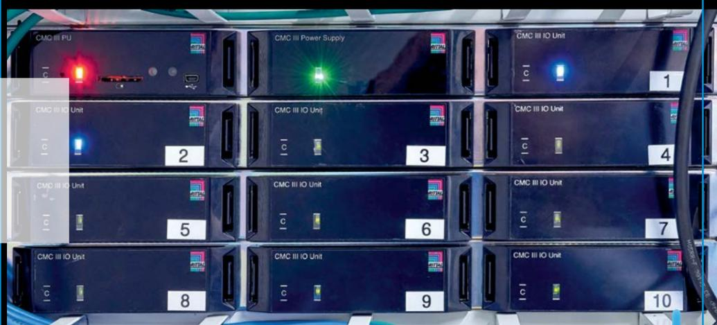
Das Rittal Monitoringsystem CMC III übernimmt die Überwachung der 23 TS IT Racks des neuen Rechenzentrums.
